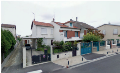
État avant transformation
